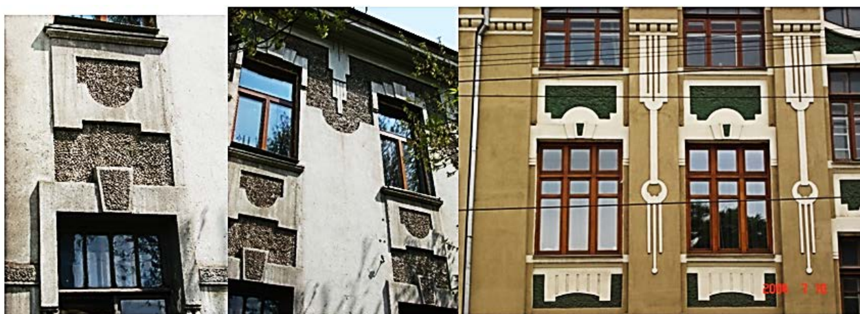
Рис. 4. Характерное использование гладкой и грубой штукатурки
