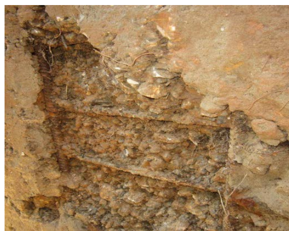
Рис. 2. Повреждения стенки резервуара
