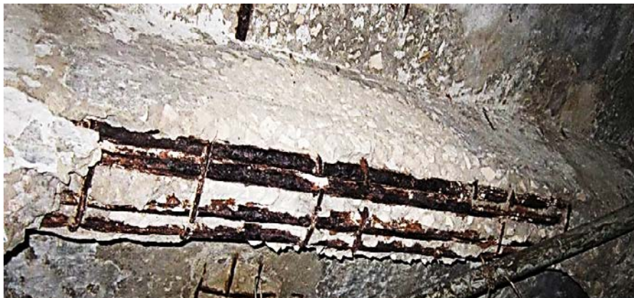
Рис. 1. Общий вид балки перекрытия
