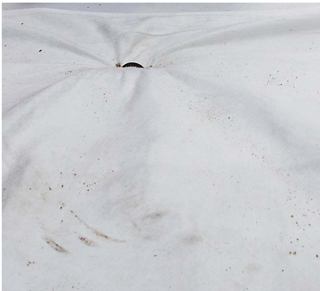
Рис. 1. Нетканый геотекстильный материал, закрепленный анкером
