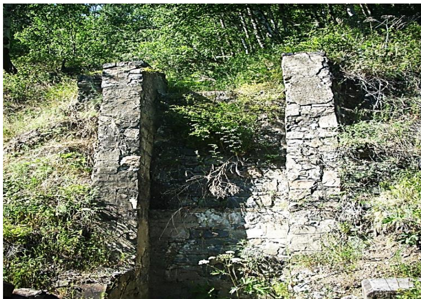
Рис. 10. Каменный водонаправляющий лоток
