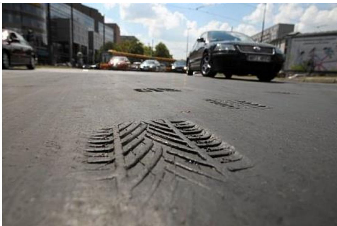
Рис. 1. Разрушение асфальтобетона при воздействии высоких температур
