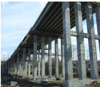
Рис. 1.6. Стойчатые опоры высокой эстакады
