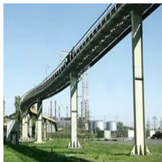
Рис. 1.6. Стойчатые опоры высокой эстакады
