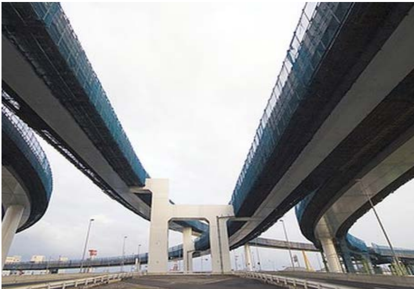
Рис. 2.10. Рамная опора транспортного пересечения
