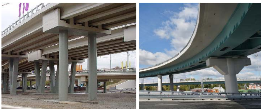
а) б) Рис. 1.4. Декоративное оформление ригелей столбчатых опор: боковыми стенками (а) и созданием рельефной поверхности (б)
