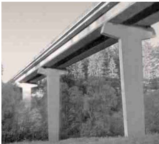
Рис. 2.5. Опора-стенка Т-образной формы
