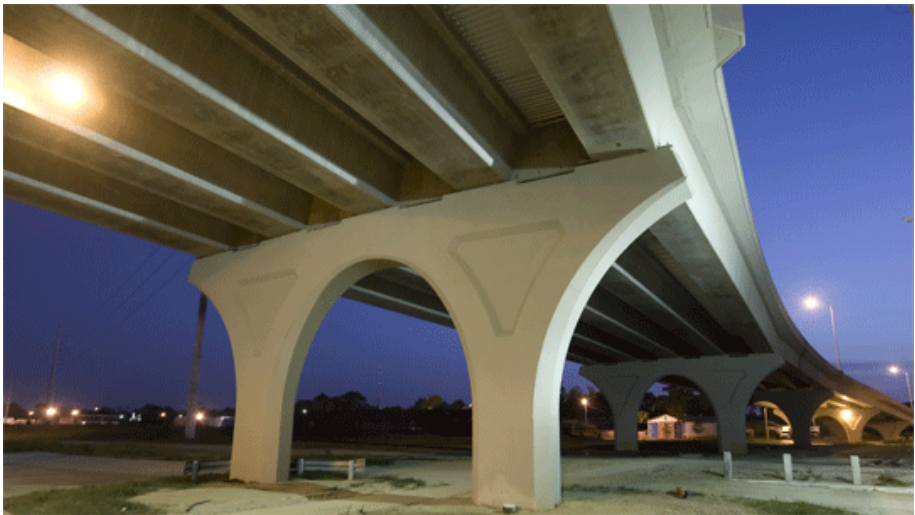
Рис. 1.1. Предварительно напряженная опора транспортной эстакады в США
