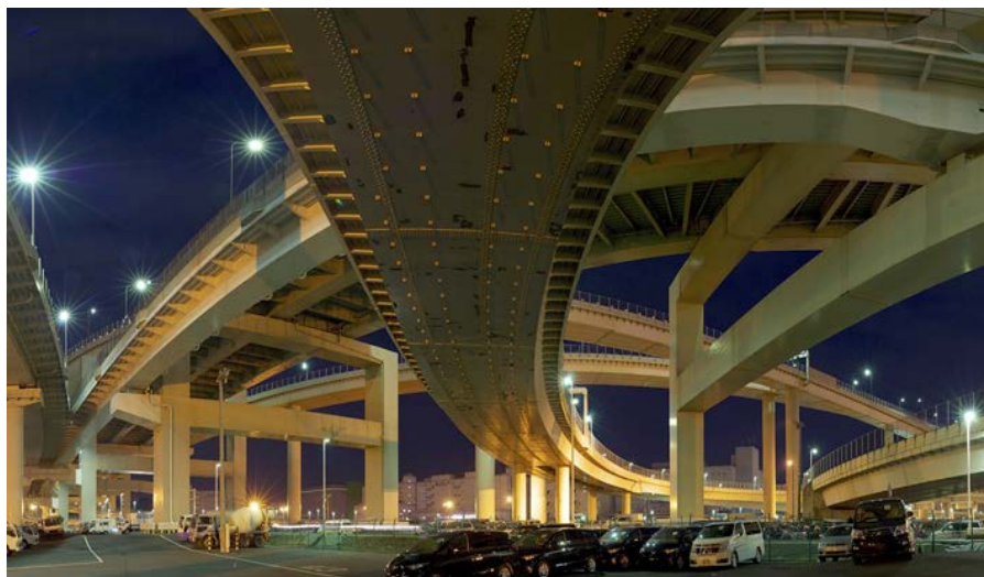
Рис. 2.8. Рамные железобетонные опоры транспортной развязки
