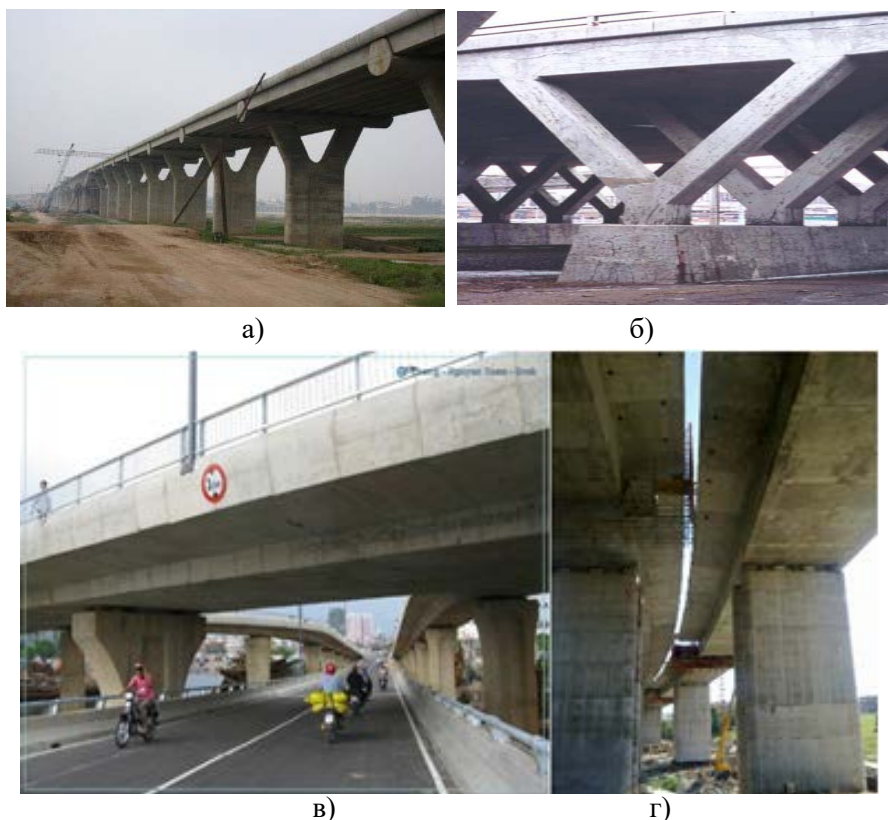
Рис.1.8. Рамные опоры: V-образные в поперечном (а) и продольном направлении (б); П – образная (в) и массивная с рамной надстройкой (г)
