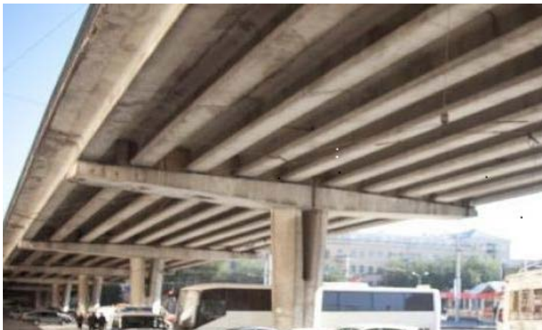
Рис.1.9. Опора Самотечной эстакады в Москве в виде Т-образной рамы
