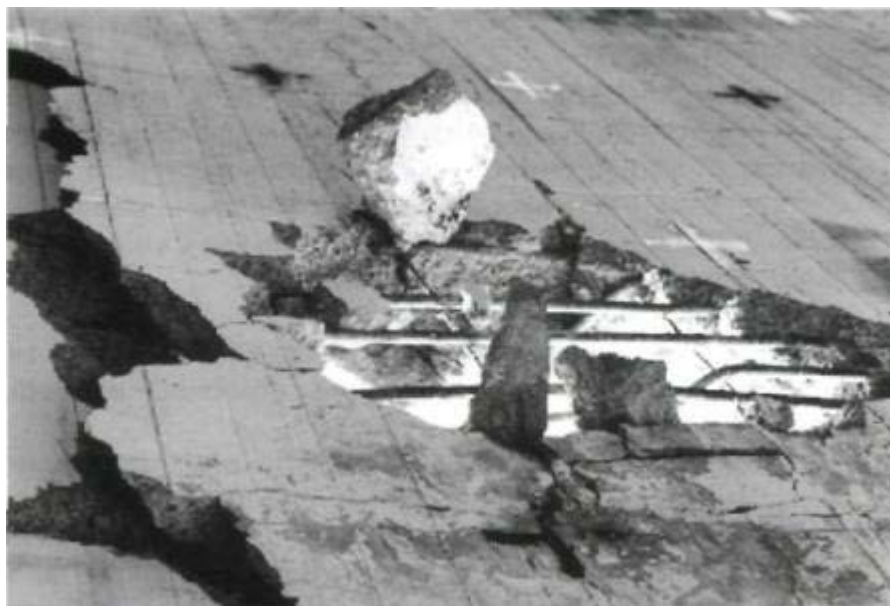
Рис. 7.1. Типичный дефект, вызванный реакцией столбчатой опоры
