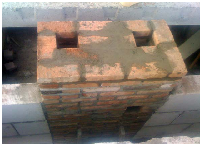
Рис. 23. Монтаж кирпичных перегородок. Фрагмент с вентиляционным каналом. Этаж 3
