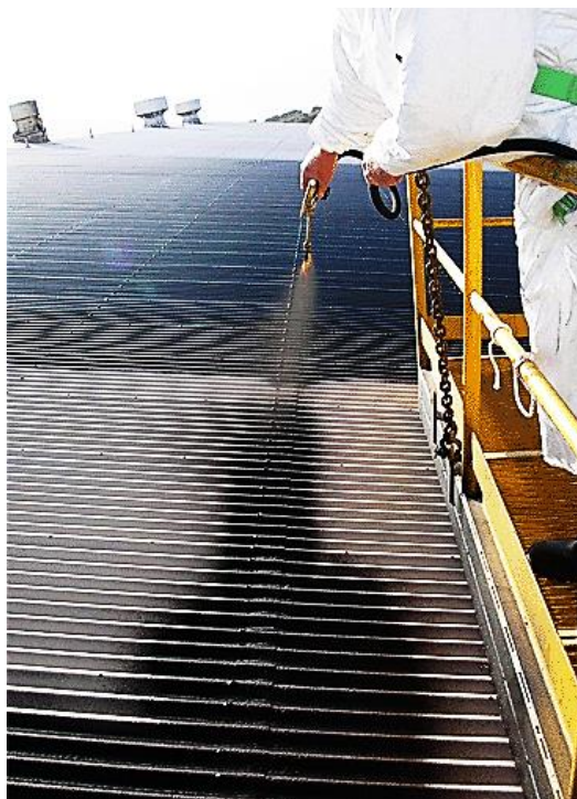
Рис. 1. Гидроизоляция жидкой резиной
