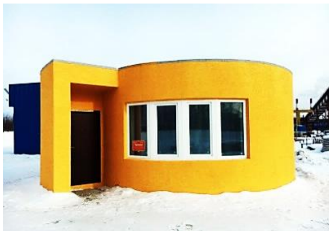
Рис. 1. Построенный дом в Ступино
