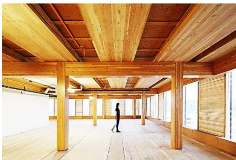
Рис. 1. Балки из LVL бруса и плиты перекрытия из CLT панелей
