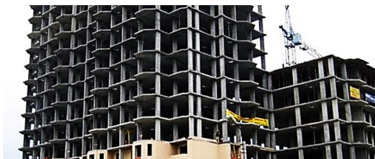
Рис. 1. Пример возведения каркасного здания
