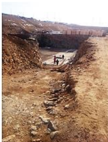
Рис. 2. Устройство котлована под производственное сооружение ГРЭС
