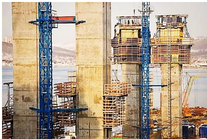
Рис. 5. Пример использования технологии скользящей опалубки при возведении ядер жёсткости
