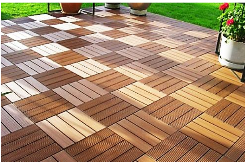
Рис. 1. Покрытие террасы досками из древесно-полимерного композита
