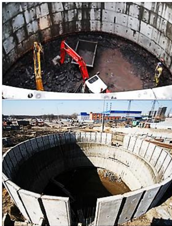
Рис. 3. Опускной колодец из монолитного и сборного железобетона
