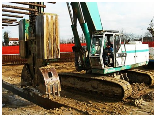
Рис. 4. Разработка траншеи грейфером
