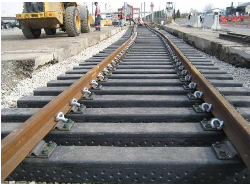
Рис. 3. Путь, уложенный на полимерных шпалах
