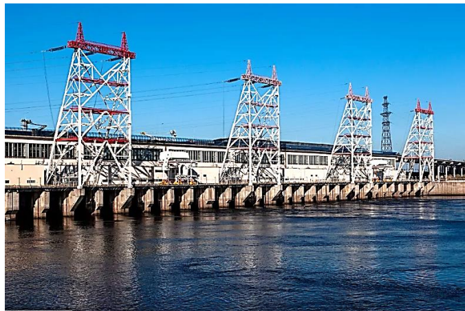
Рис. 1. Гидротехническое сооружение. Новочебоксарская ГЭС
