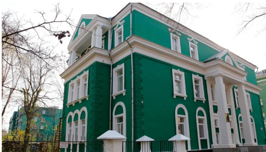
Фото 5. Здание ДМШ №1, г. Пермь
