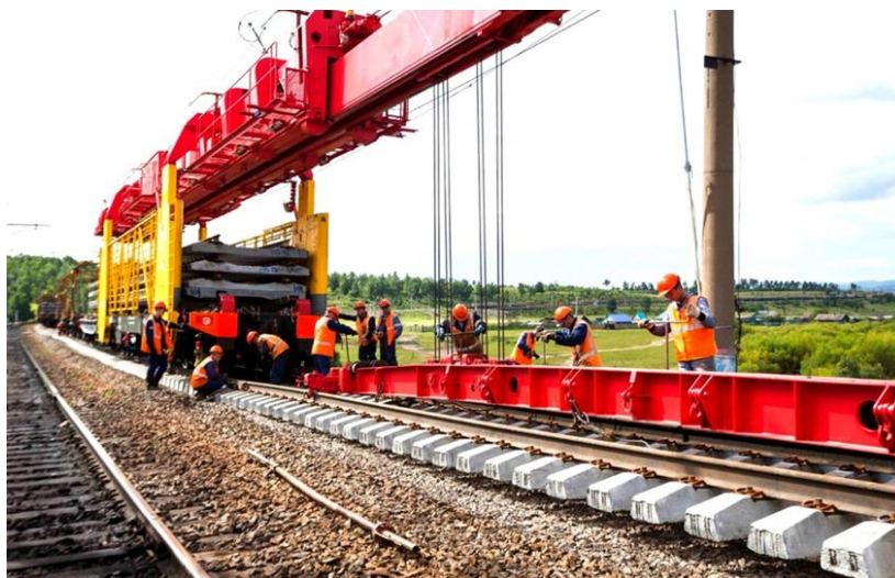
Рис. 1. Капитальный ремонт железнодорожного пути
