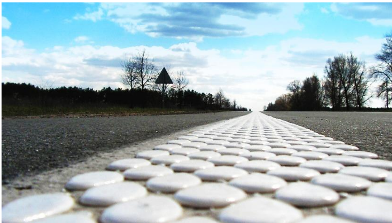
Рис. 4. Шумовые полосы в виде кнопок
