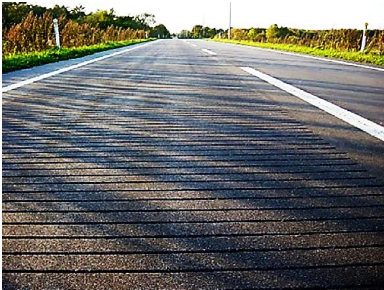
Рис. 1. Шумовые полосы на автомобильной дороге
