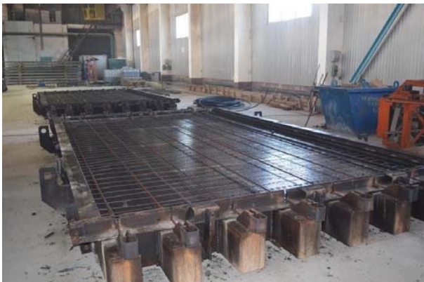
Рис. 2. Производственный цех по производству дорожных плит
