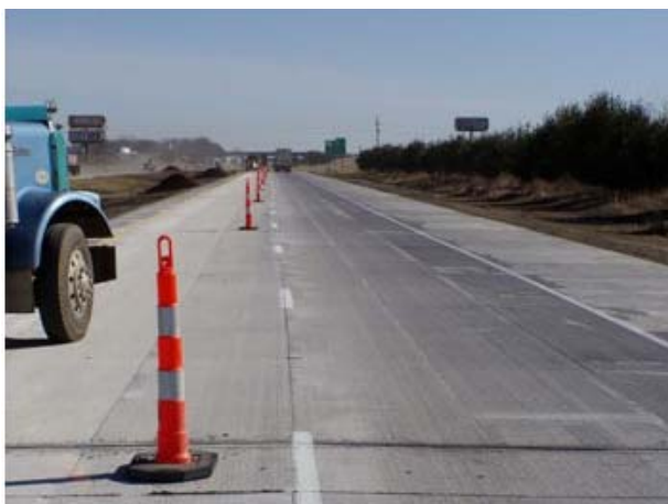
Рис. 3. Фрагмент дороги с цементобетонным покрытием
