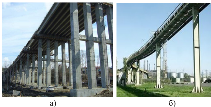
Рис. 1.6. Стойчатые опоры высокой эстакады
