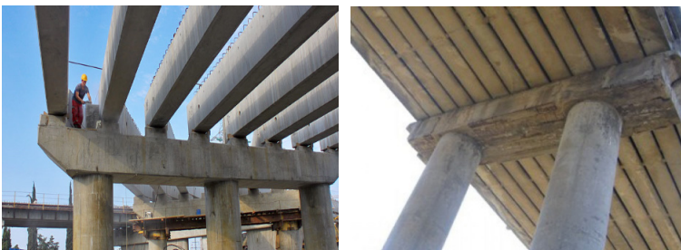
Рис.1.10. Опоры с тремя (а) и двумя (б) столбами и объединяющим ригелем
