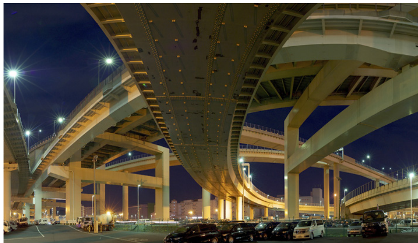
Рис. 2.8. Рамные железобетонные опоры транспортной развязки
