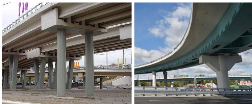
а) б) Рис. 1.4. Декоративное оформление ригелей столбчатых опор: боковыми стенками (а) и созданием рельефной поверхности (б)
