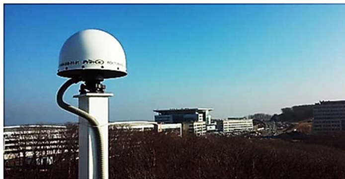
Рис. 1 ГНСС референчная станция
