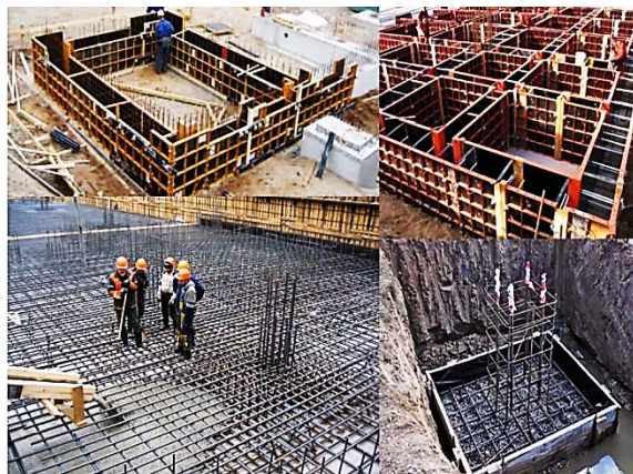
Рис. 1. Пример устройства монолитного железобетонного фундамента
