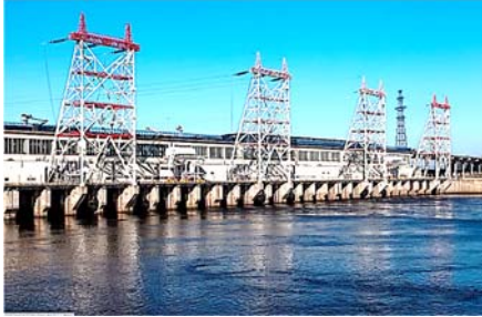
Рис. 1. Гидротехническое сооружение. Новочебоксарская ГЭС
