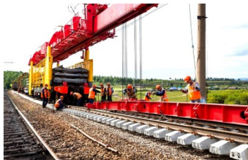
Рис. 1. Капитальный ремонт железнодорожного пути
